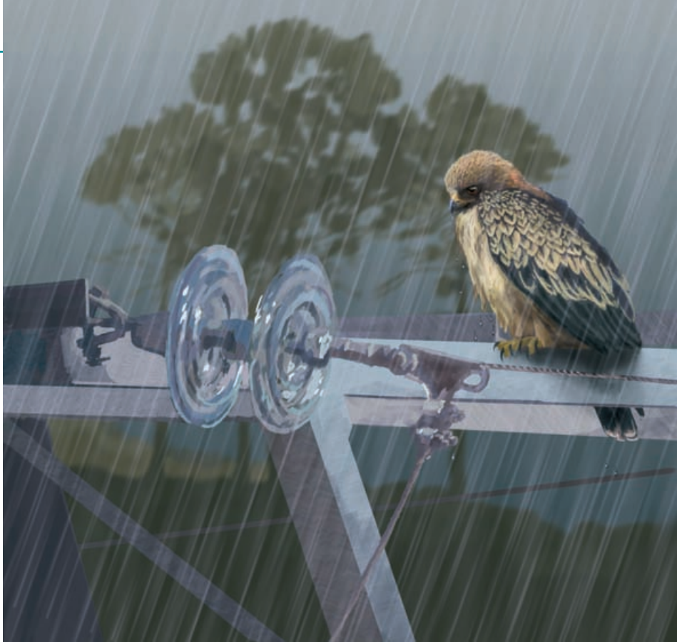
Figura 4. Aguililla calzada ( Hieraetus pennatus ) sobre un apoyo de amarre. Condiciones meteorológicas de viento y lluvia propician la electrocución. Las plumas secas constituyen un buen aislante, pero el contacto entre plumas mojadas y conductores es 100 veces más peligroso que con plumas secas (Nelson, 1979; 1980).
