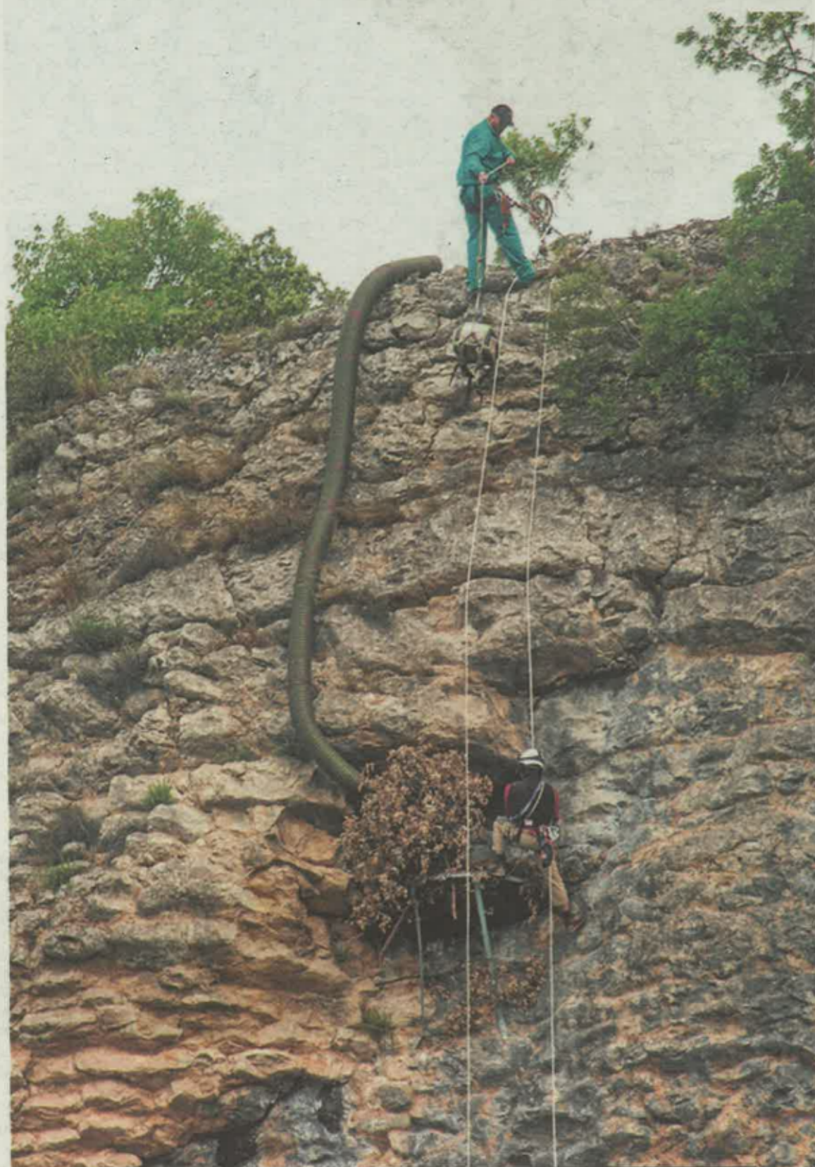
Dos técnicos durante la compleja construcción del nido, que se alimenta a través del tubo. :: E. C.
