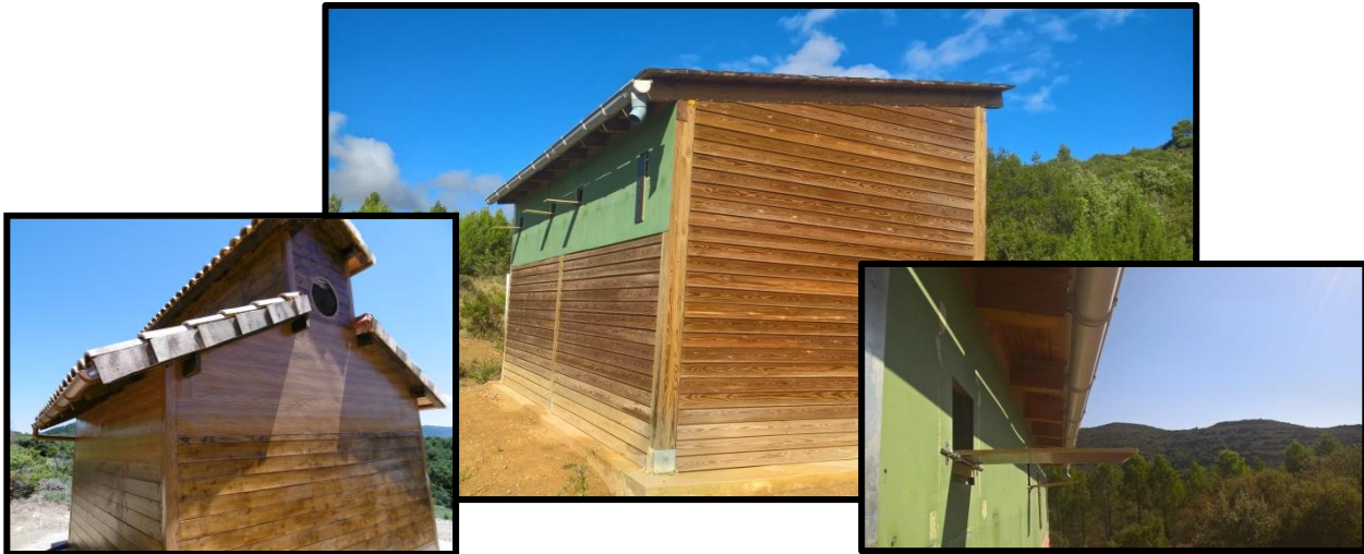
Detalle de los sistemas anti depredación. Plancha de metacrilato en Álava (izda.) y plataformas basculantes en Navarra
