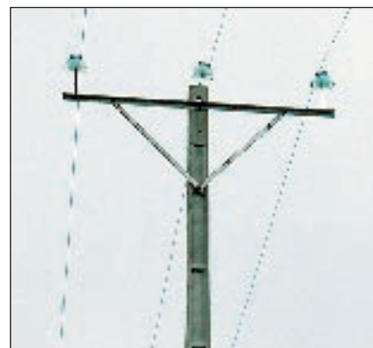
Poste eléctrico con aisladores rígidos.
