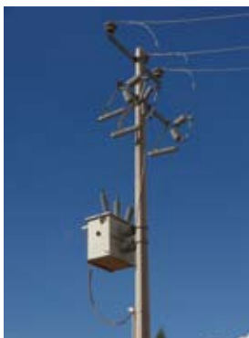
Transformador con boquillas y puentes expuestos
