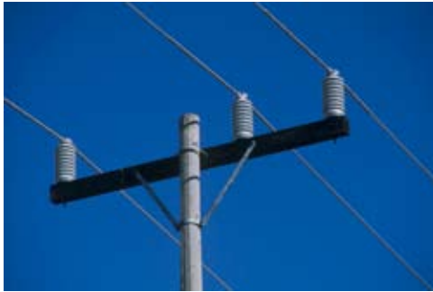
Estructura modificada con cruceta de madera
