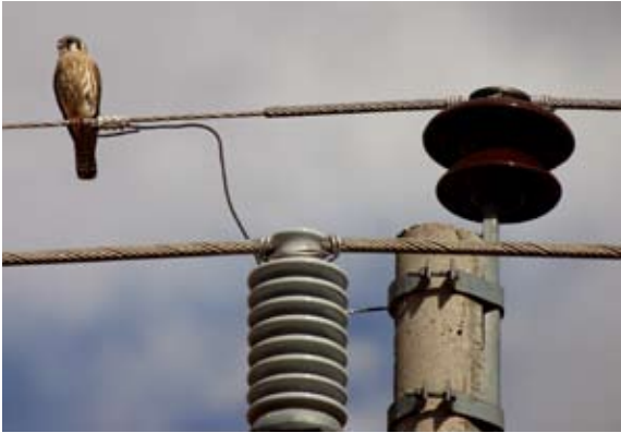
Cernícalo posado sobre estructura con aisladores tipo alfiler y tipo poste
