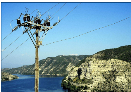
Fig. 4: Línea de distribución en ZEPA de Matarraña-Aigüabarreix (riesgo de electrocución y colisión).
