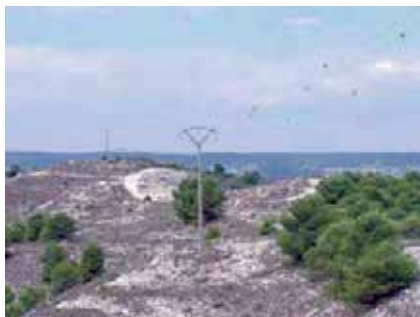
Der. (15 Kv) al Repetidor de Valmadrid.
