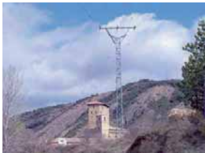
Lín. (17 Kv) de Biel y Der. a Fuencalderas.
