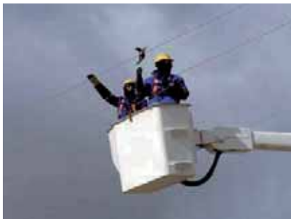
Detalle colocación de balizas salvapájaros en tensión.
