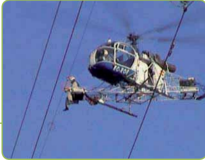
Colocación mediante helicóptero de balizas salvapájaros en los hilos de tierra de un tendido de transporte, con la línea en tensión.
