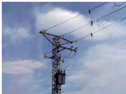
Conductores y puentes fijos aislados.
