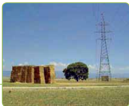
Tendido de transporte señalizado dentro del Proyecto LIFE-Naturaleza de la Unión Europea.
