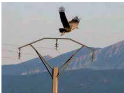
Apoyo en bóveda y aisladores suspendidos.
