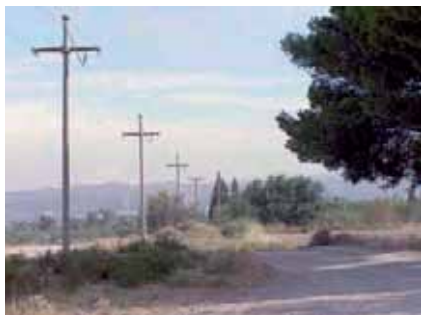
Der. (15 Kv) a Mot. de Acequia de Fuentes de Ebro.
