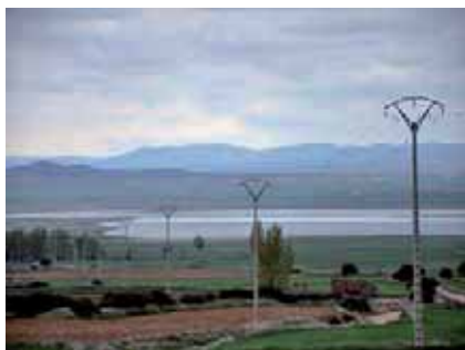
Der. (15Kv) a motobombas de Los Arenales.
