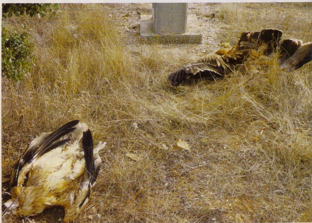
Dos pollos de águila imperial yacen electrocutados bajo el poste de un tendido eléctrico del término municipal de Torre de Juan Abad (Ciudad Real).
