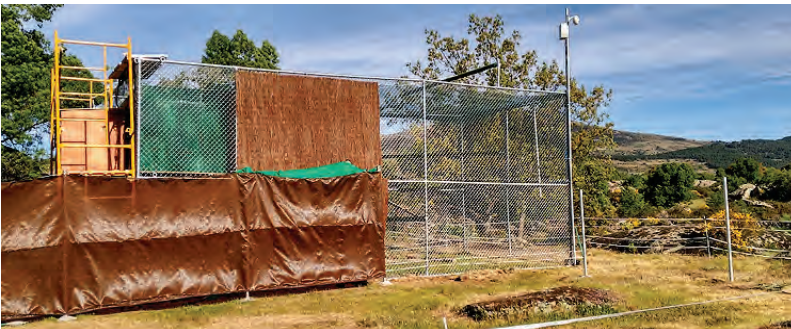
Figura 5.- Aspecto del lateral de la instalación construida en 2017 en Madrid por GREFA. Se observa la cámara de videovigilancia y el pastor eléctrico que protege todo el entorno inmediato.
