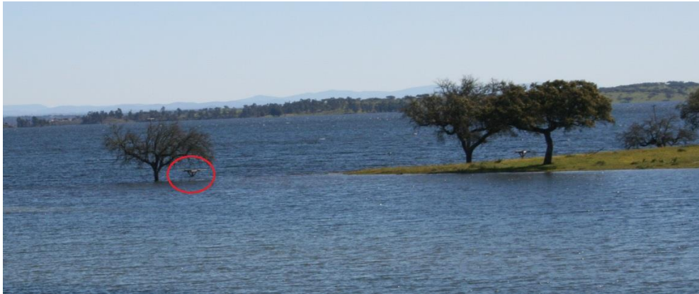
Figura 13. Alimentadores parcialmente submersos devido a subida no nível de água da barragem.
