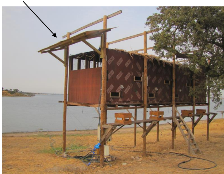
Figura 1. Painel de sombra lateral indicado pela seta. Foto Denis Landenbergue.
