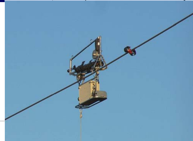
INSTALACIÓN DE SALVAPÁJAROS EN CONDUCTORES DE FASE
