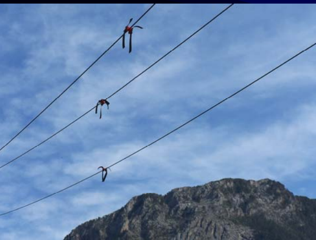
INSTALACIÓN DE SALVAPÁJAROS EN CONDUCTORES DE FASE
